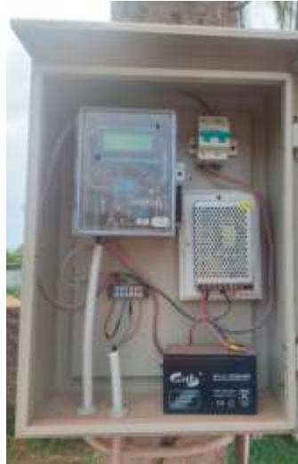
ຮູບຟາບທີ 4: ການຕິດຕັ້ງສະຖາວັດແທກເຂົ້າກັບໝໍ້ແປງຈຳໜ່າຍ 0.4KV
